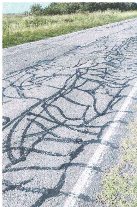
Figura 5. Sellado de fisuras, ahuellamientos y bacheos
