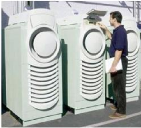
ejemplo de 3 microturbinas trabajando en paralelo.
