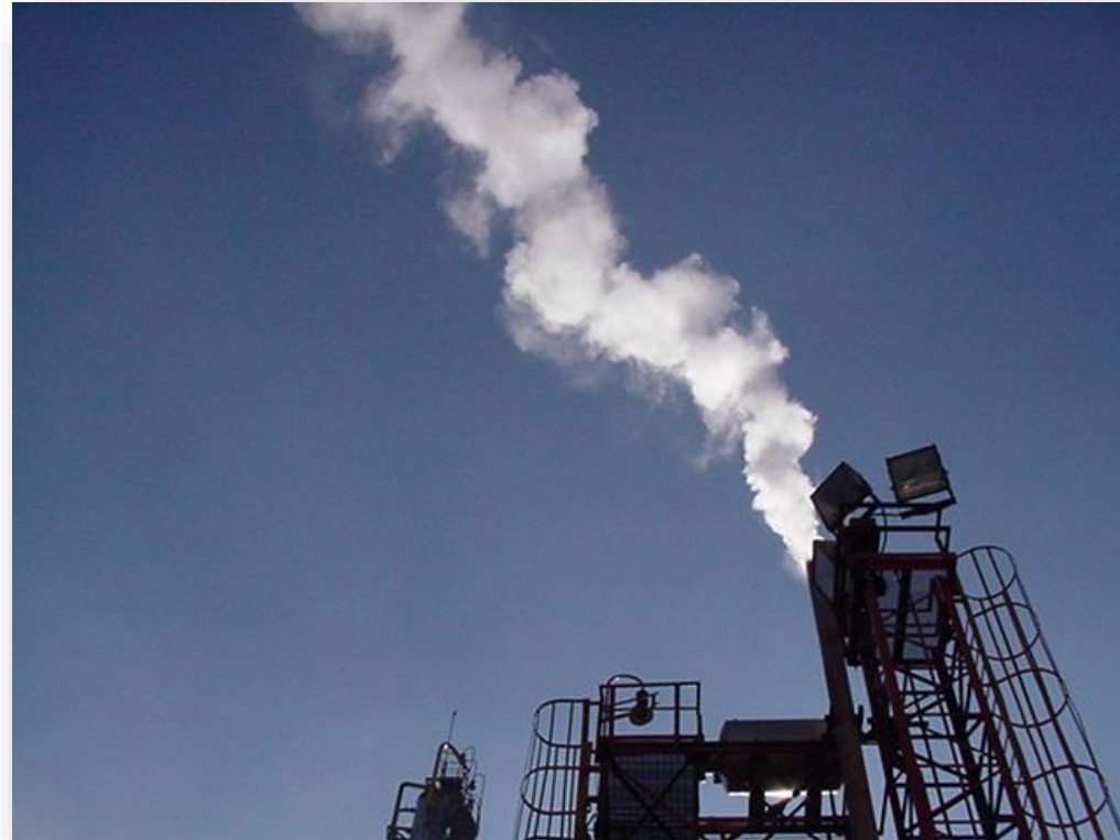
Condensadores de superficie de turbinas a condensación: 1.6 t de FO equiv/día
