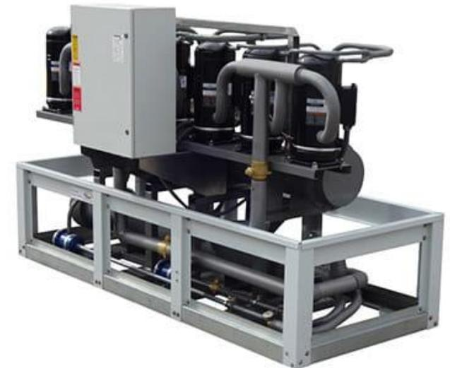
Foto de chiller de tipo scroll enfriado por agua (Cortesía de EcoChillers)
