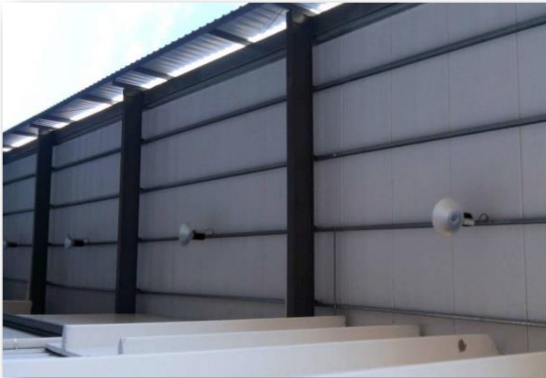
Foto de techo de paneles de espuma de poliuretano (Cortesía de Tecnomateriales )
